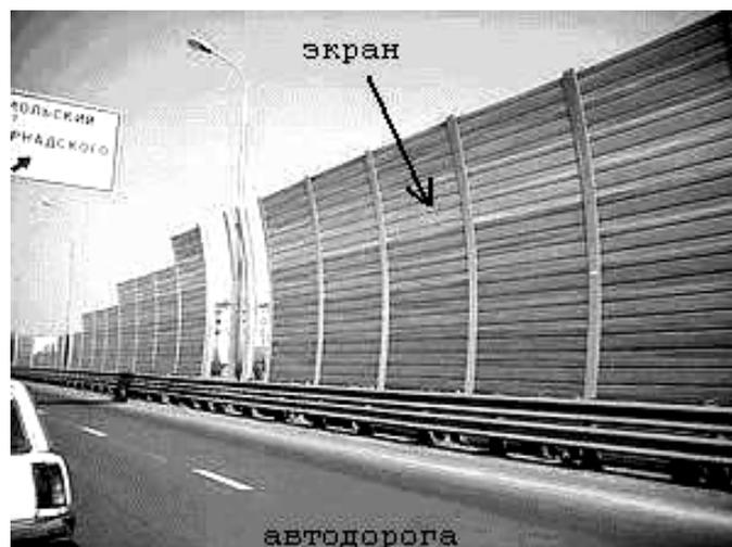
**Рисунок 10 — Шумозащитный экран**
