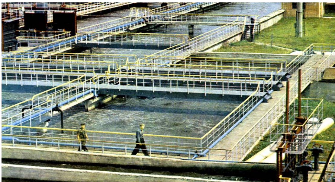
Рисунок 2 — Станция очистки сточных вод
